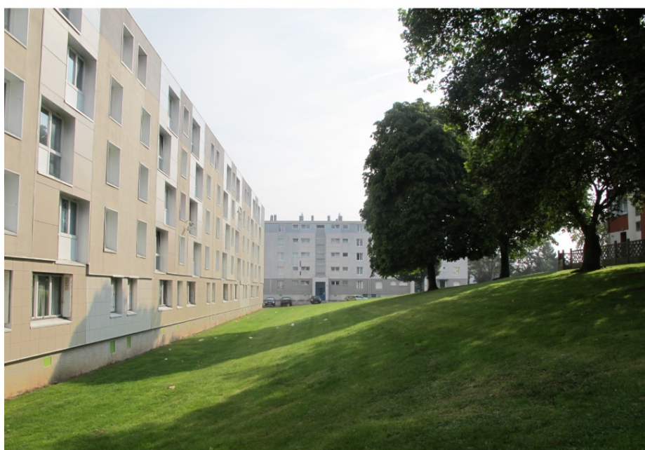
Les barres de logements R+4 (85 à 145m de long)
